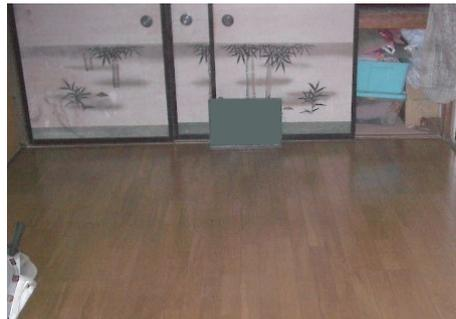
改修例2) 引き戸に交換して、開口部を拡げる
